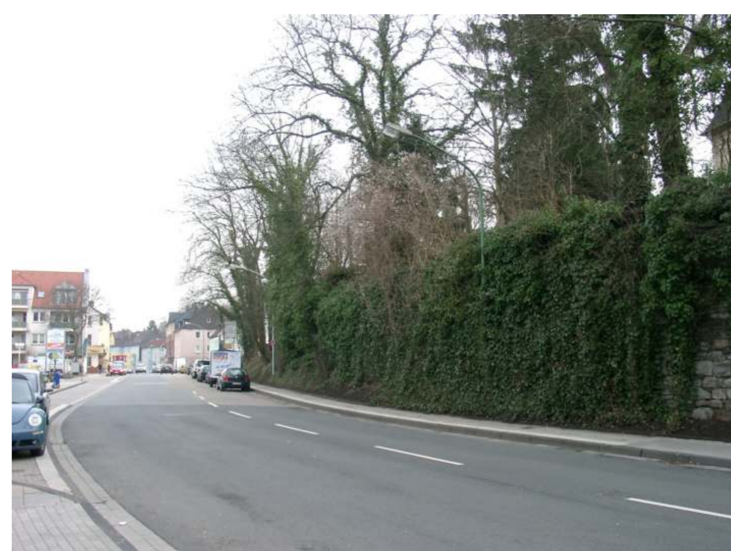
Stützmauer an der Kupferdreher Straße
